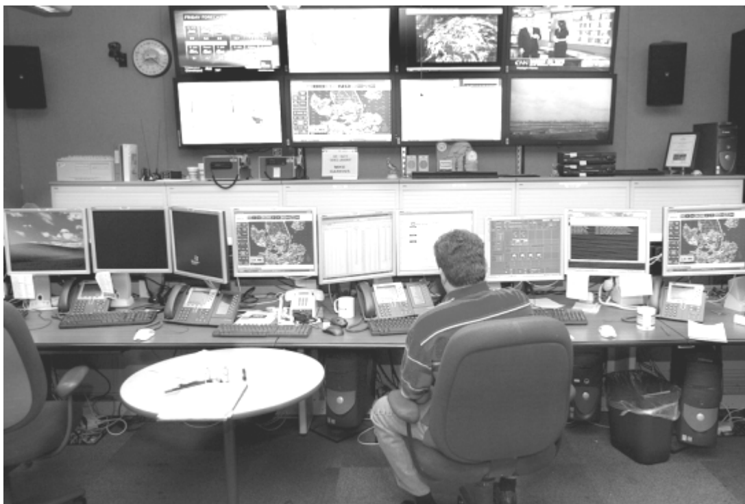
南佛罗里达水处理厂使用 SCADA 软件系统进行监管
